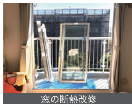
窓の断熱改修
