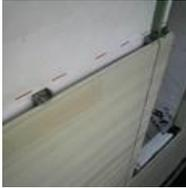
通気金具止金具とする場合は、通気胴縁を設けないことができます。施工の簡略化が可能となります。
