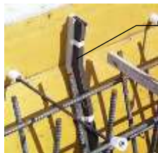
誘発目地 コンクリート打設前
